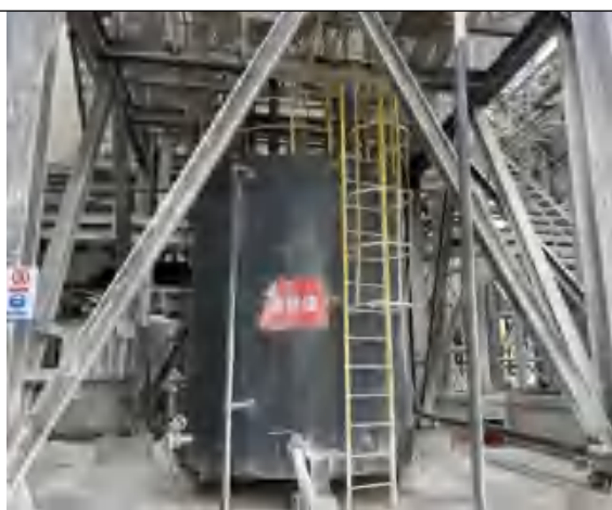
石灰浆制备间
