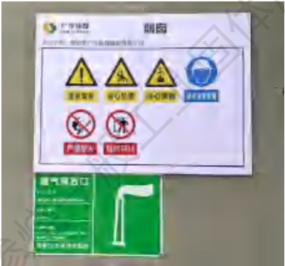
2号焚烧炉废气排放口环保标识牌
