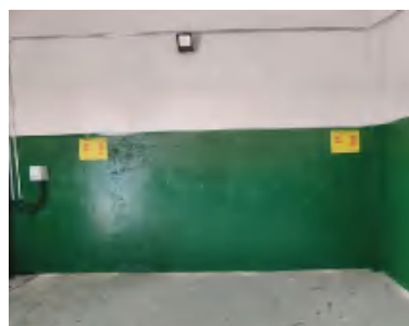
危险废物暂存间内部分区标志
