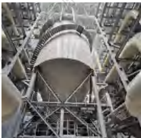
焚烧炉烟气处理-脱酸塔
