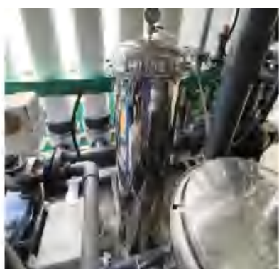
工业废水处理（保安过滤器）
