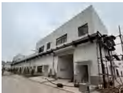
污水处理系统
