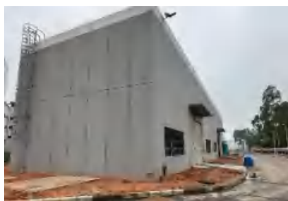
飞灰固化物养护间及危废暂存间
