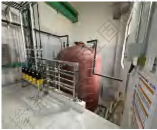
盐酸储罐区（围堰、收集沟渠等）
