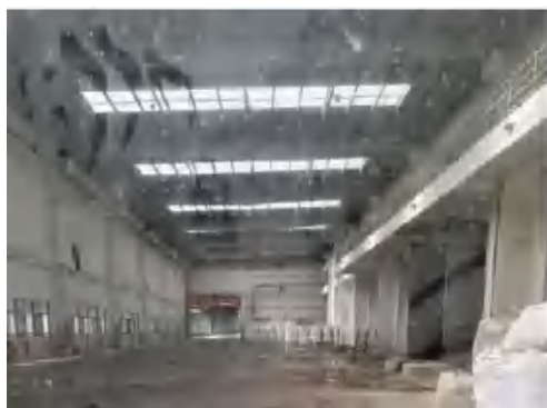
垃圾卸料大厅
