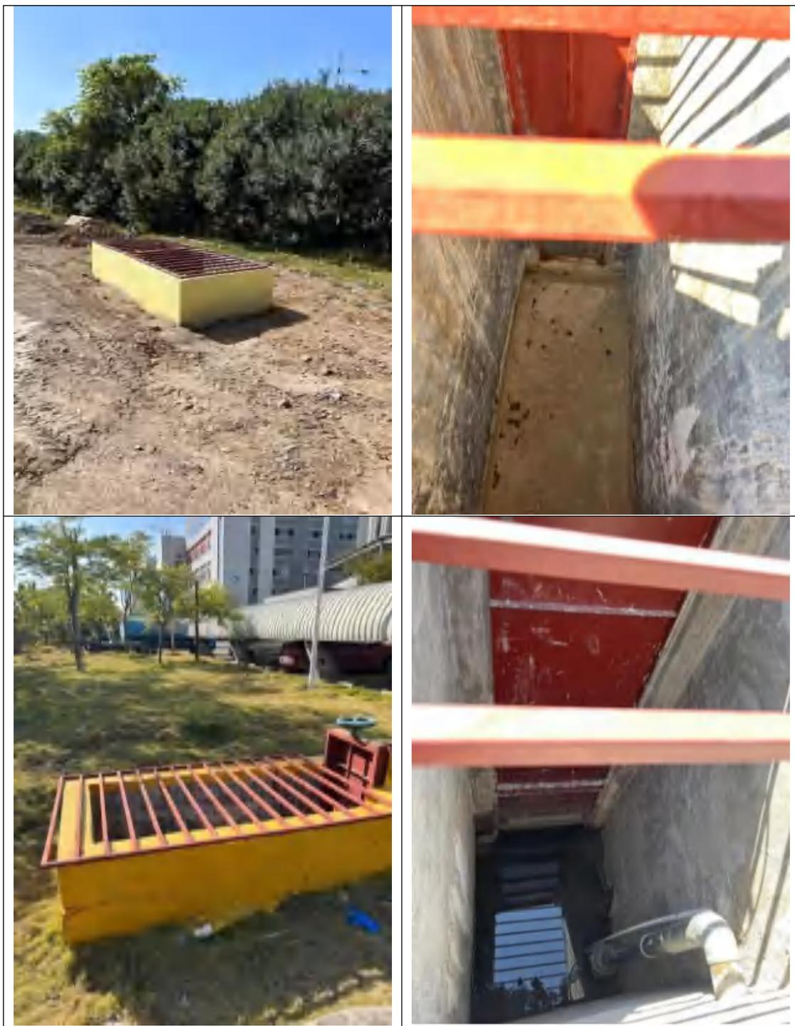
图 3.1-17 表处园雨水管道风险防控改造图
