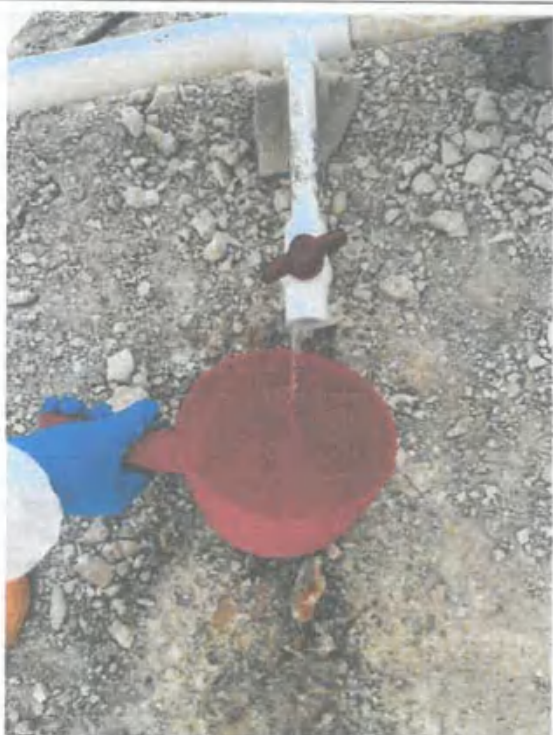
图 9.3 综合废水人工湿地处理后排放口 ★W3
