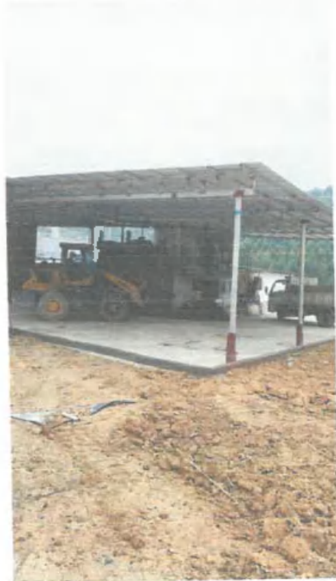
现场粪渣处理区硬底化防渗处理及围堰设置
