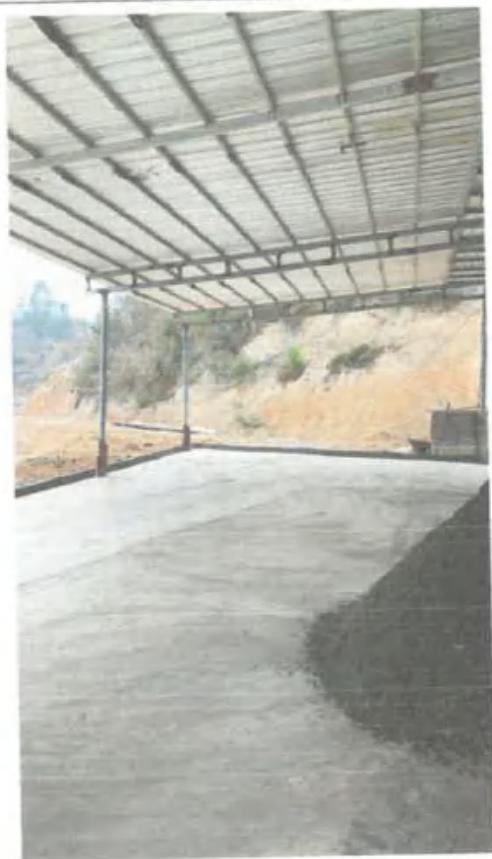
现场粪渣处理区硬底化防渗处理及围堰设置
