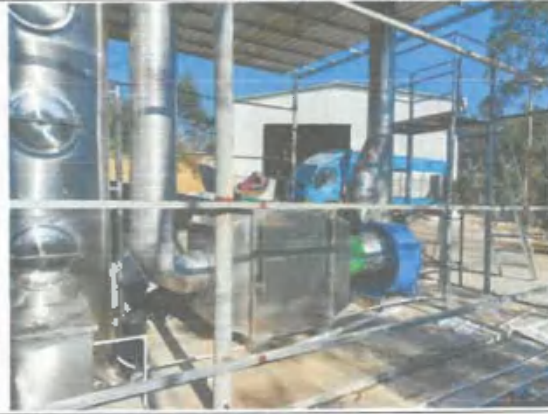
无害化处理设施尾气处理设备
