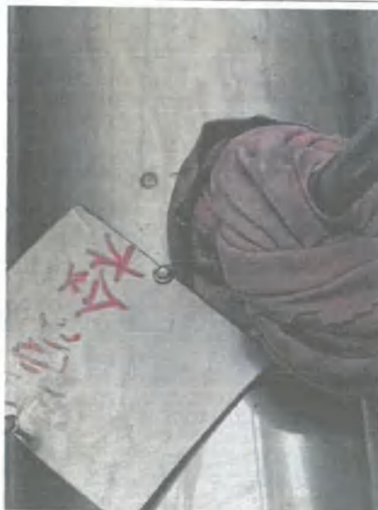
图 9.4 综合废气处理后检测口 ○Q3
