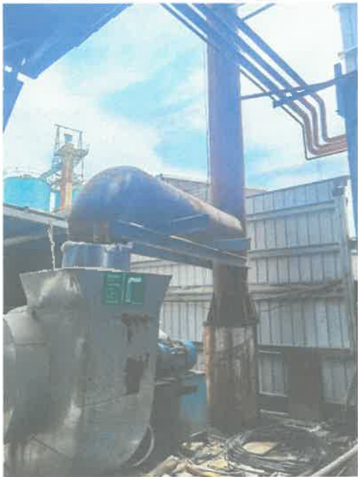
退火炉燃烧废气排放口2# (DA004) 规范化
