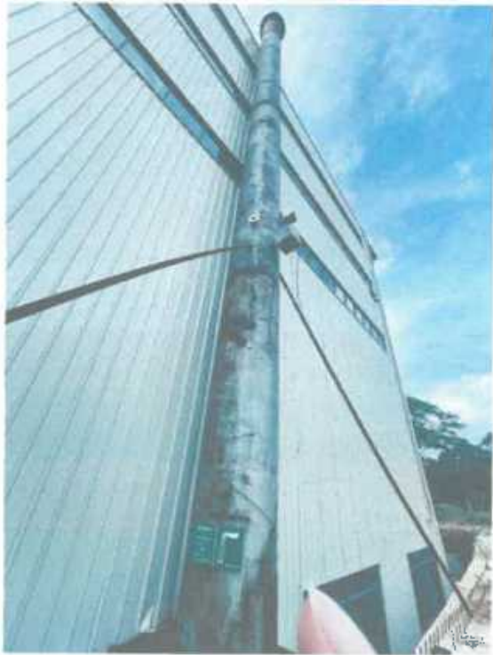
退火炉燃烧废气排放口 3# (DA006) 规范化
