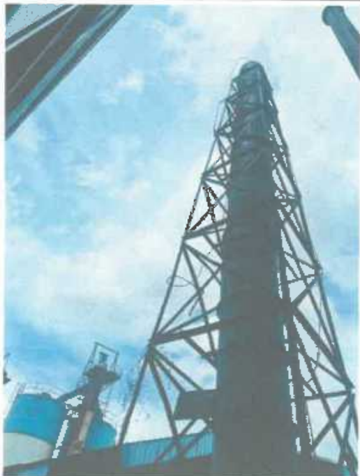
除油清洗工艺废气排放口 2# (DA002) 规范化
