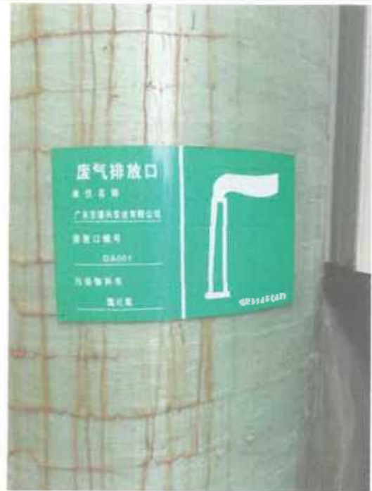
酸洗工艺废气排放口 1# (DA001) 规范化
