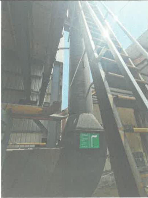
锅炉燃烧废气排放口1# (DA003) 规范化
