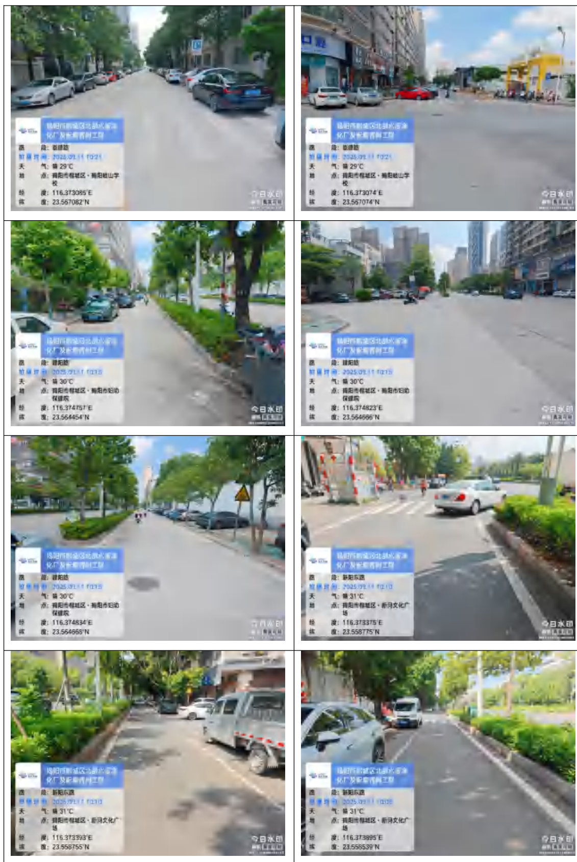
附图 2 管网生态修复措施图片
